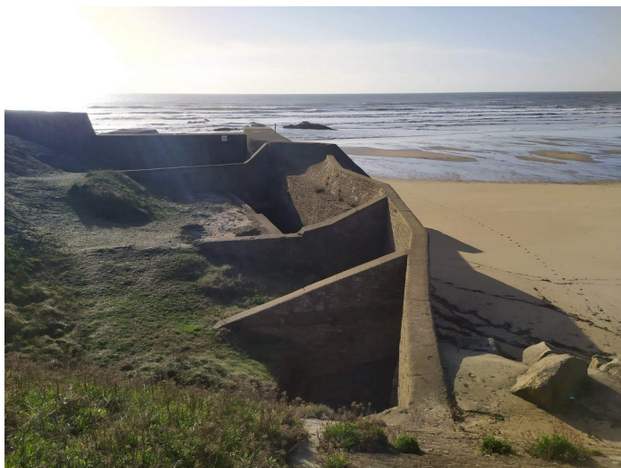
Figure 9: Digue à clapets entre la mer et les Étangs du Loc'h (C. ROSSIGNOL)
