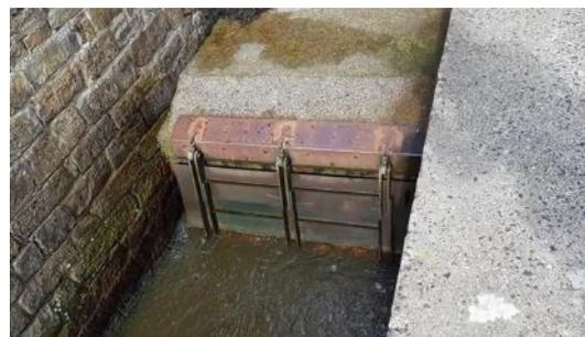
Figure 1 : Photographie d'une vanne à clapets
