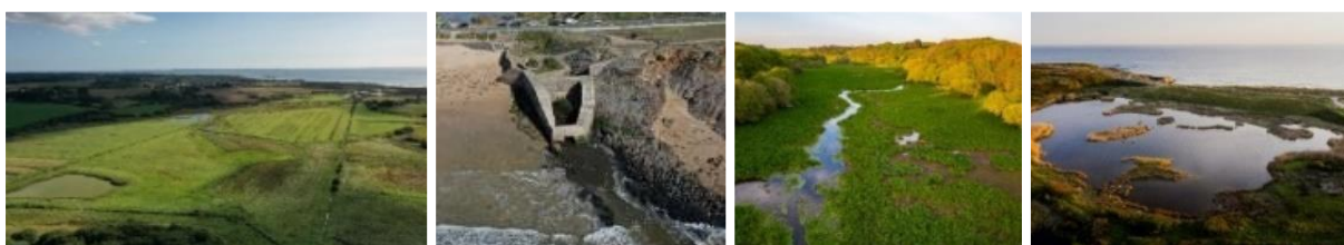
Figure 3 : Ci-dessous de gauche à droite : polder du Grand Loc’h, ouvrage de débouché en mer (ART&FACT, 2021), vue aérienne de la vallée de la Saudraye et vue aérienne du Petit Loc’h (Emmanuel Berthier, 2020)
