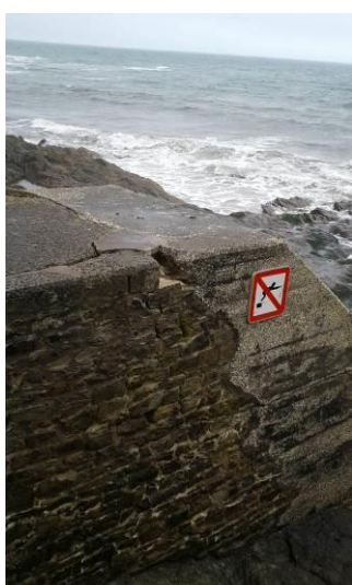
Figure 38 Dégradation de l'ouvrage de sortie en mer de la Saudraye
