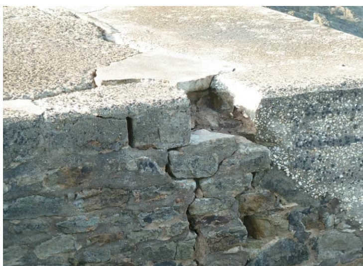
Figure 38 Dégradation de l'ouvrage de sortie en mer de la Saudraye
